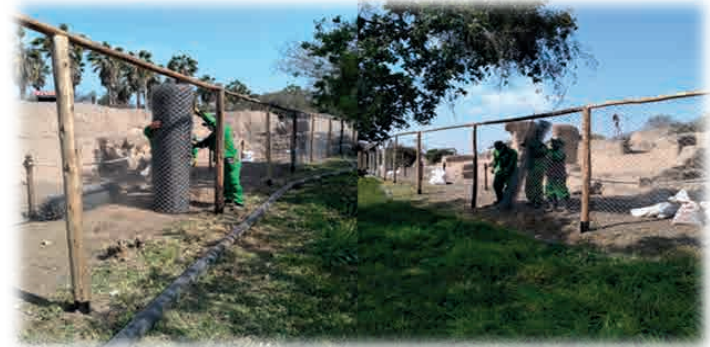
Colocación de mallas metálicas nuevas del perímetro.
